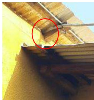
Rem : une douille est à changer dans la salle d'accouchement. La gaine qui protège le câble entre le local SHS et la maternité sera à changer prochainement (exposition au soleil).
