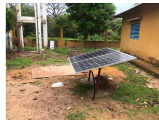
Réhabilitation pompage solaire et sanitaires poste de santé Balandine
